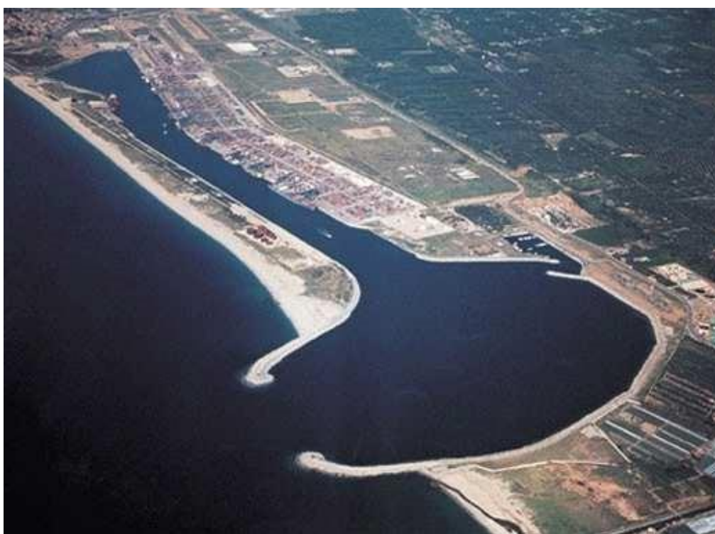
INFRASTRUTTURA - PORTO DI GIOIA TAURO
